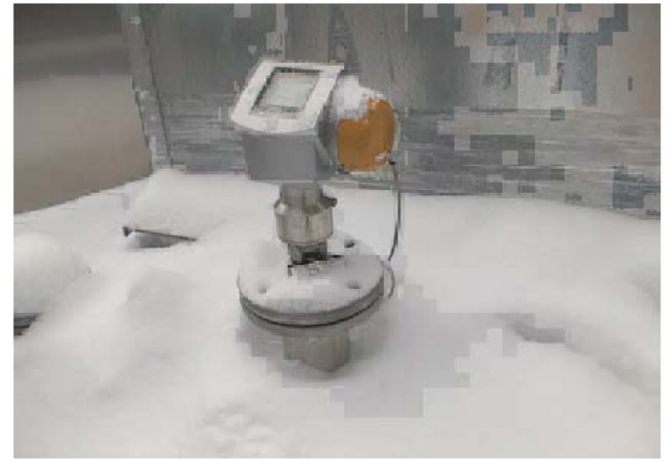
VF7. Bentonite. 11m. Steel
